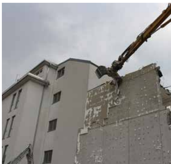
EPS-Dämmabfall, der bei Abbrucharbeiten entsteht, soll künftig vermehrt recycelt werden. Bild: Fraunhofer Austria
