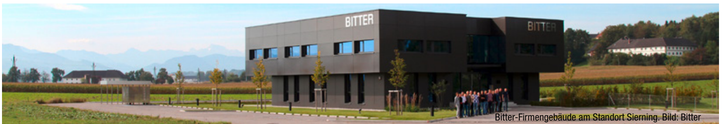
Bitter-Firmengebäude am Standort Sierning. Bild: Bitter
