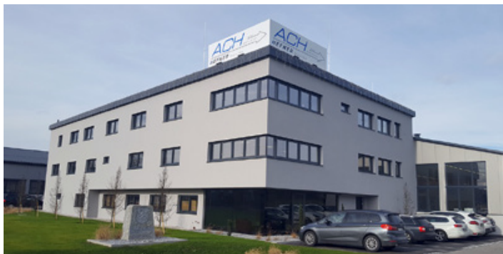
ACH Solution investierte 2017 3 Mio. Euro in Gebäude und Maschinen. Bild: ACH Solution
