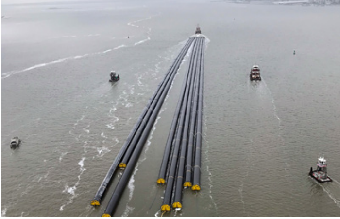
Mit Schleppschiffen wurden die bis zu 523 m langen Großrohre über 25.000 Kilometer Seeweg vom Produktionsstandort in den Vereinigten Staaten bis in den Mittleren Osten gezogen. Bild: AGRU
